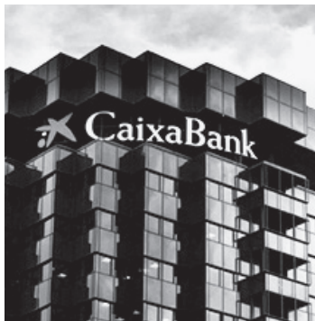
Sede de La Caixa en Barcelona.
